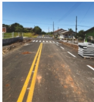
Pavimentação asfáltica na Rua São Carlos.
