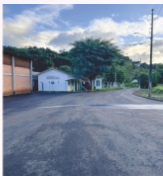
Pavimentação asfáltica no centro da comunidade de Linha Barra Grande.
