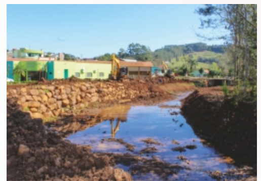
Alargamento, dragagem e limpeza do leito do rio Lajeado Cunhataí, na extensão de 1 km
