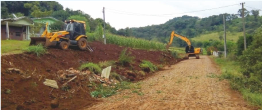
Preparação de base e limpeza para asfalto rural.
