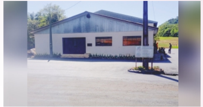
Pavimentação asfáltica no centro da comunidade de Linha Cambará.
