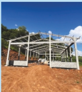
Construção de um barracão de 450 m 2 .
