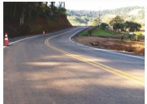
Pavimentação asfáltica rural na Linha Aliança.
