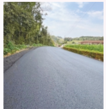
Pavimentação asfáltica rural Linha Alegre.
