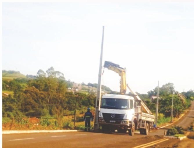
Ampliação da rede de iluminação pública
