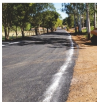
Pavimentação asfáltica no centro da comunidade de Linha São Roque.
