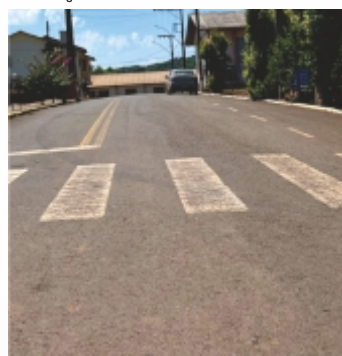
Pavimentação asfáltica na Rua Nossa Senhora da Salete.
