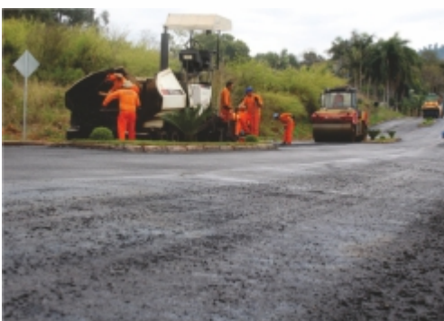
Pavimentação asfáltica na Avenida 04 de Julho.
