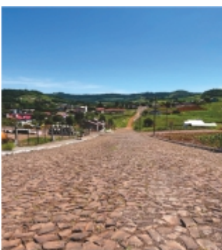
Pavimentação com calçamento na Rua Sereno Endler.
