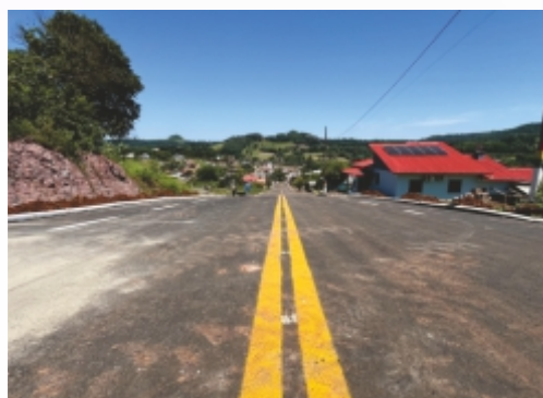
Pavimentação asfáltica na Rua João Sehnem.
