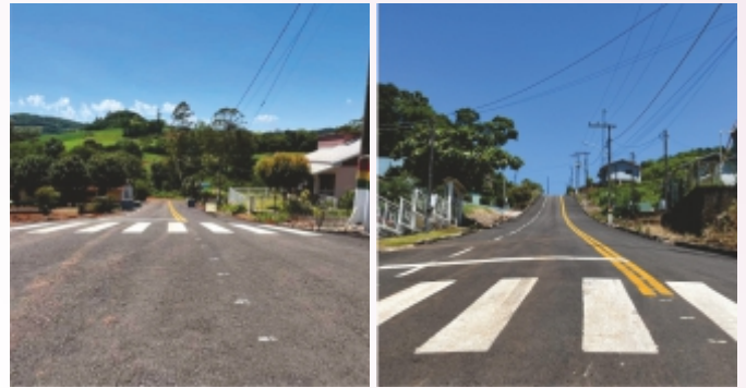
Pavimentação asfáltica na Rua Romana Werlang.
