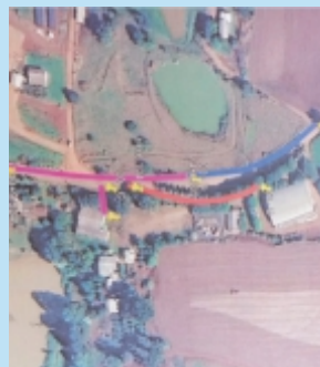
Asfalto no centro da Comunidade de Santa Cecília.
