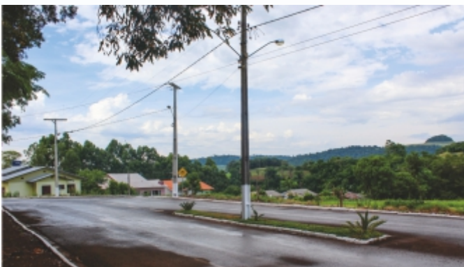
Realocação de postes de luz em ruas e avenidas.
