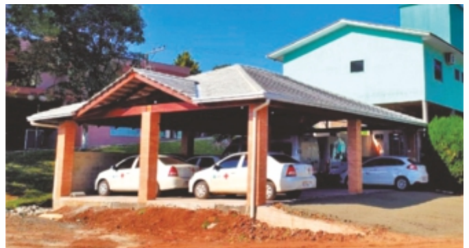
Construção de garagem para guarda de veículos da Secretaria de Saúde e Saneamento.
