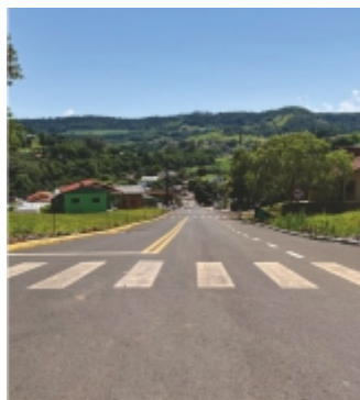
Pavimentação asfáltica na Rua Mathias Theisen.
