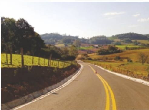
Pavimentação asfáltica rural – Linha Barra Pequena sentido Linha São Roque.
