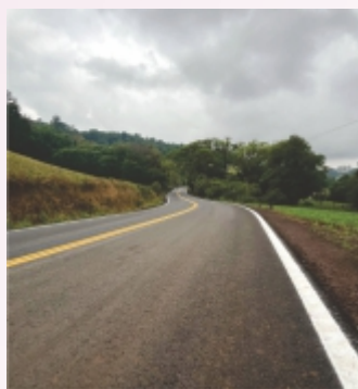
Início da restauração do pavimento asfáltico ao acesso a Saudades, 1,2 km.
