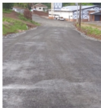
Pavimentação asfáltica rural no sentido Linha Aliança/Linha Santa Cecília.
