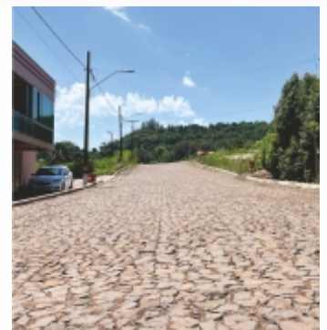
Pavimentação com calçamento na Rua Felipe Diel.
