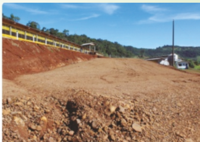
Programa de auxílio terraplanagem.
