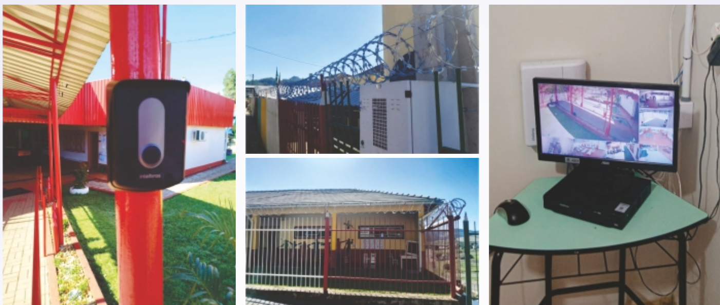
Instalação de cercas, interfone e câmeras de segurança nas escolas municipais.
