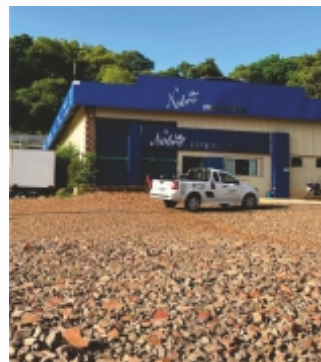
Construção de barracão industrial.
