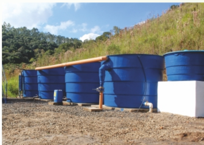
Reforma e ampliação da rede de água da Linha Três Rosas.
