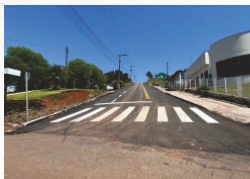
Pavimentação asfáltica na Rua Engenheiro Agrônomo Estevão Mathias Franken.
