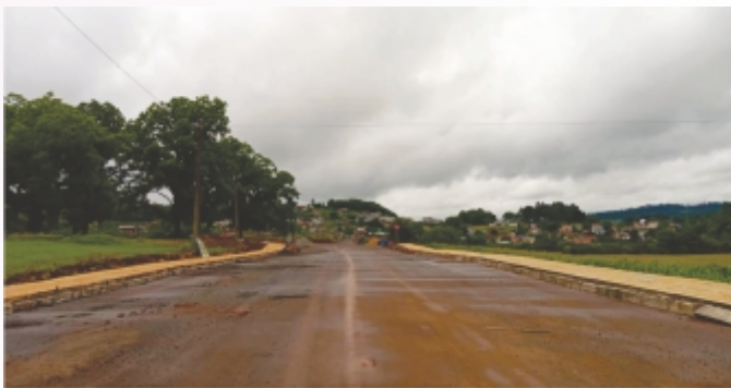
Pavimentação asfáltica na Avenida 29 de Setembro.
