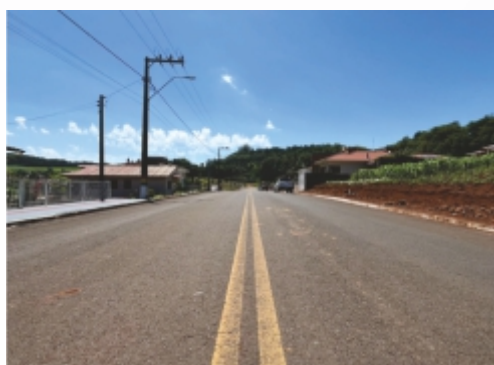
Pavimentação asfáltica na Rua Felipe Diel.
