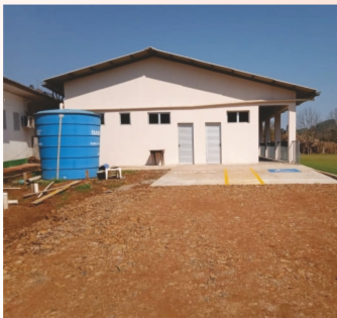
Construção de sede esportiva na Linha Barra Grande.
