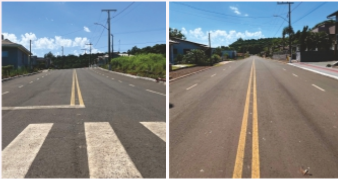
Pavimentação asfáltica na Rua José Kerbes.
