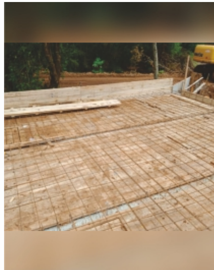
Instalação de pontes Barra Grande.
