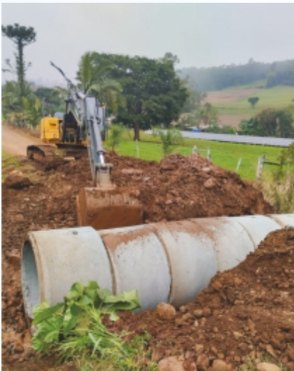
Colocação de tubos nas estradas gerais.
