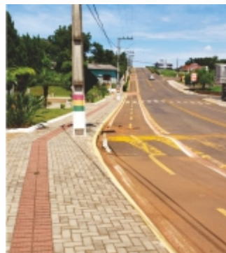
Obras de acessibilidade em órgãos públicos.
