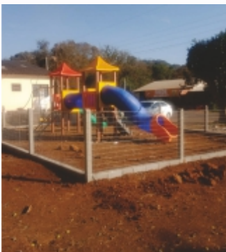
Construção de Parquinho na Linha Cambará.
