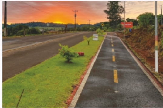
Construção e iluminação de ciclovia.
