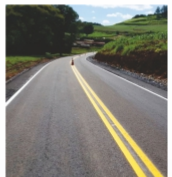
Pavimentação asfáltica sentido Linha Barra Grande.
