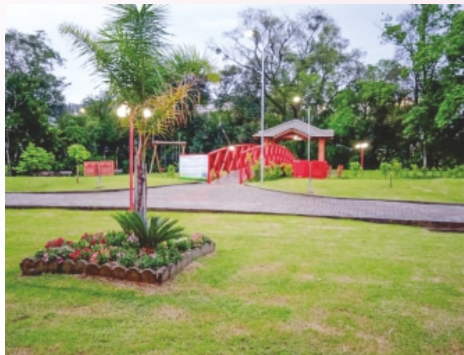
Construção da área de lazer anexa ao Lajeado Cunhataí.
