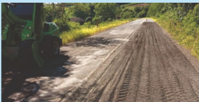
Revitalização de 1,3 km de asfalto sentido Saudades.
