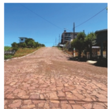
Pavimentação com calçamento na Rua São Roque.
