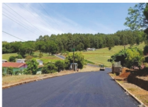
Pavimentação asfáltica na Rua João Sehnem, sentido Linha Barra Grande.
