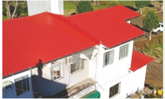
Revitalização estrutural do telhado da Unidade Básica de Saúde.
