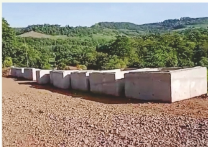
Instalação de 06 de passadores de gado.
