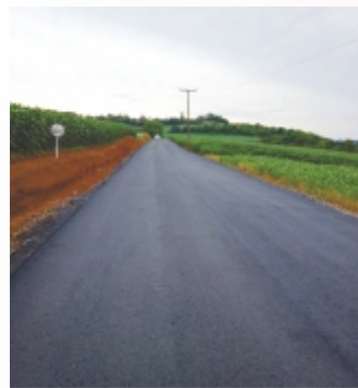
Pavimentação asfáltica rural Linha Barra Pequena.
