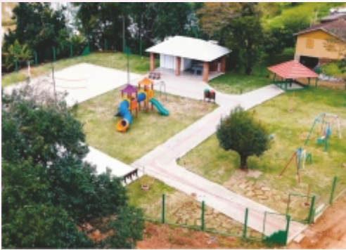
Construção de praça na Linha Santa Cecília.
