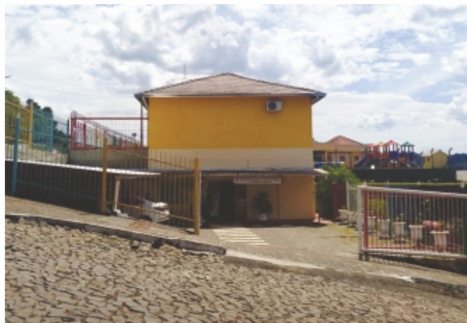
Construção da nova sede da Secretaria de Educação.
