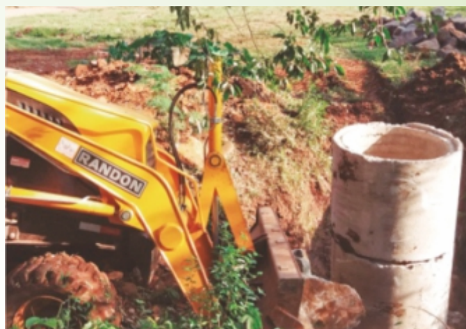
Abertura de poços.
