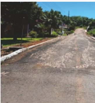
Pavimentação com calçamento na Rua Santa Cecília.
