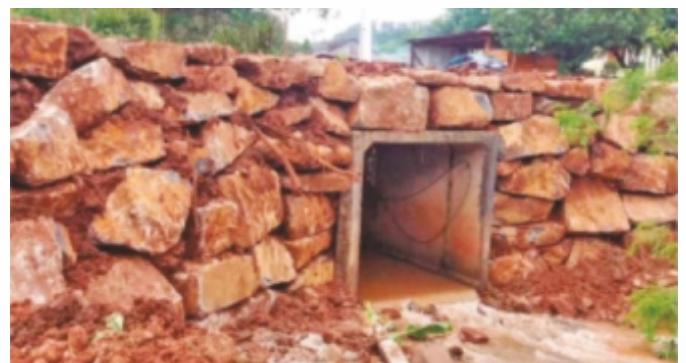
07 pontes feitas em galerias.
